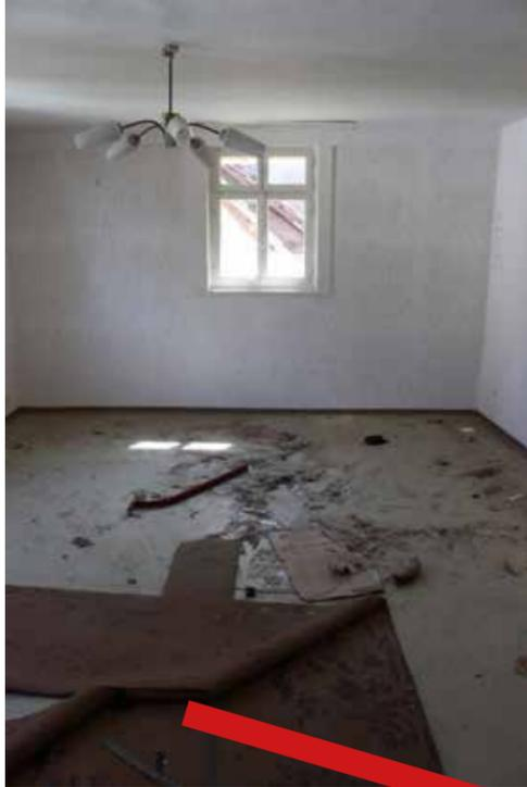
Den ekligen PVC-Boden habe ich rausgerissen, die Kleberreste und den Boden abschleifen war eine riesen Sauerei. Von den 120 Liter Staubfangsäcken der Bodenschleifmaschine die ich mir ausgeliehen habe sind vier voll geworden. Das Holz der Dielen ist extrem hart - gealterte Lärche. Was mich über 15 Schleifbänder gekostet hat...
