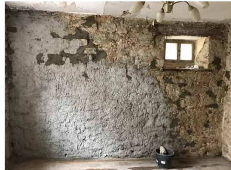
Zimmer 1 im Erdgeschoß- ich habe die alte Tapete und Gipsputz von Wänden und Decke runter, neu verputzt, gestrichen und den Boden geschliffen.
