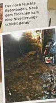
Der noch feuchte Betonboden. Nach dem Trocknen kam eine Nivellierungsschicht darauf
