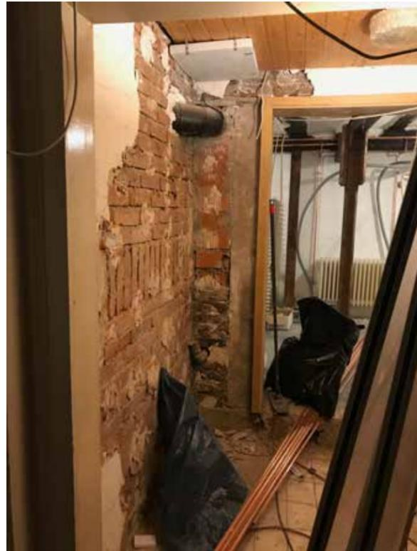
Das alte Bad... rausreißen, Bauschutt wegfahren, Wasserleitungen neu verlegen (hat die Firma S3 gemacht), Wand verputzen, dann Wand verkleiden, Tür einpassen, Waschbecken und Duscharmatur montieren, nur das Klo habe ich dann wieder vom Installateur machen lassen
