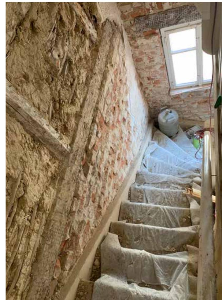
Den Gipsputz im ganzen Haus runter habe ich geklopft und anschließend mit Kalkputz neu verputzt. Die schadhafte Stellen an der Treppe ausgebessert, geschliffen und die ganze Treppe neu gestrichen, die Stufen geölt...
